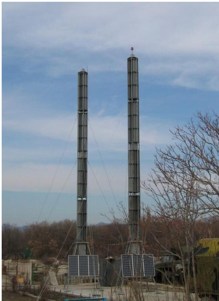
**Рис.12. Двухагрегатная комплексная энергосистема с ВРТБ - 5 при питании пограничной заставы ЧАБО.**
