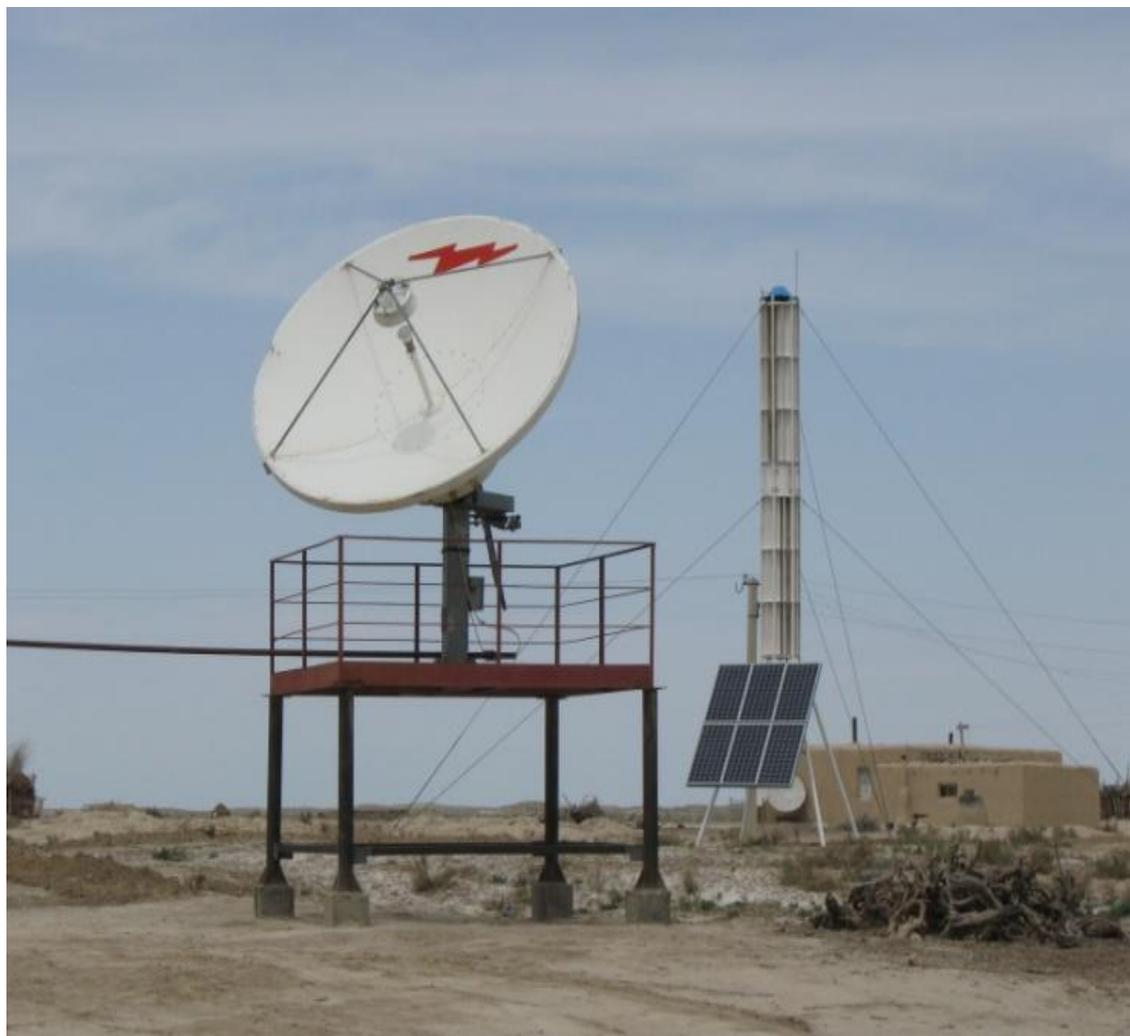
**Рис 15. КЭС ВРТБ -2,6 на объекте АО «Казакхтелеком» Ажар одновременно обеспечивает питание электронного оборудования школы, интернет, интерактивную классную доску.**
