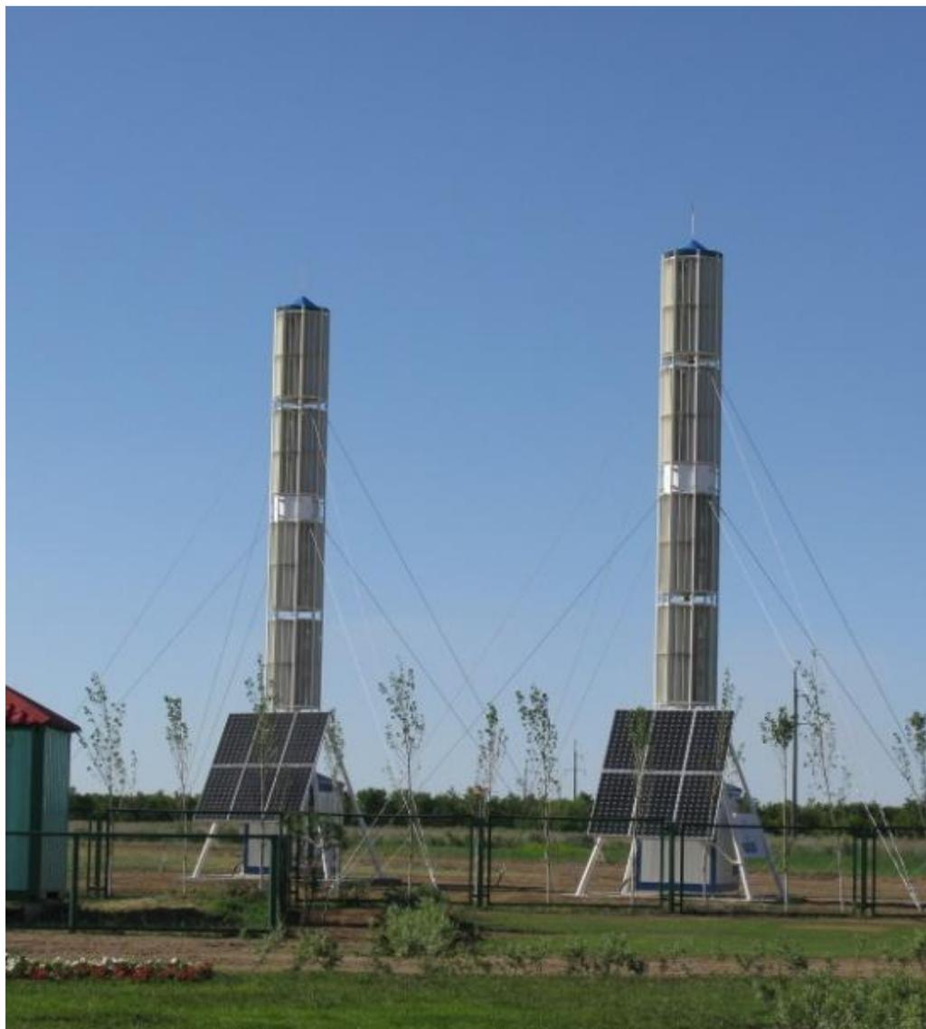
**Рис 19. Комплексные энергетические системы ВРТБ, по 5 кВт каждая.
